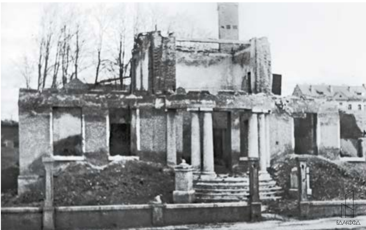
Вид на разрушенное здание амбулатории туберкулезного диспансера г. Минска (1944 г., АН А38-073)
