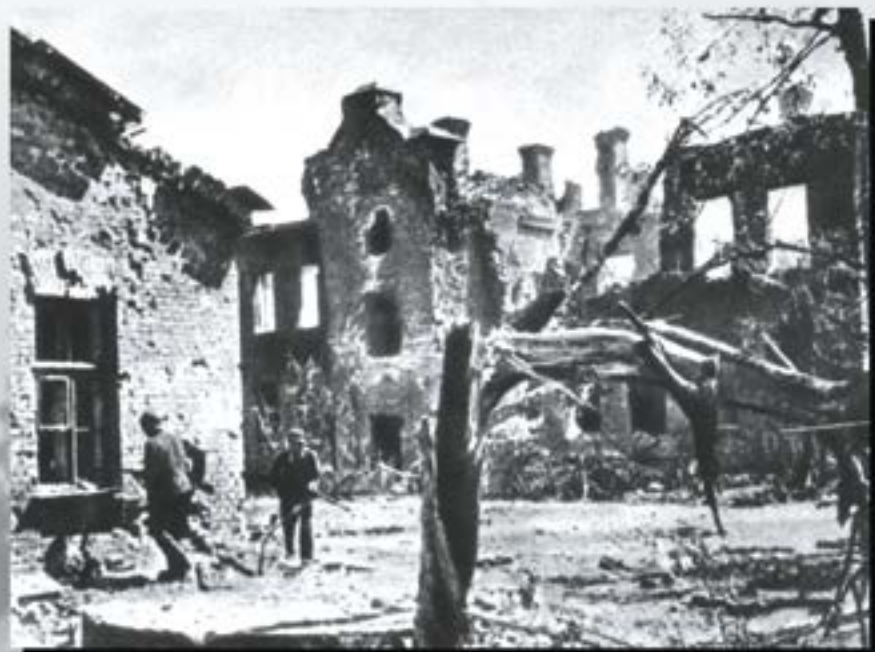
Разрушенный г. Брест
