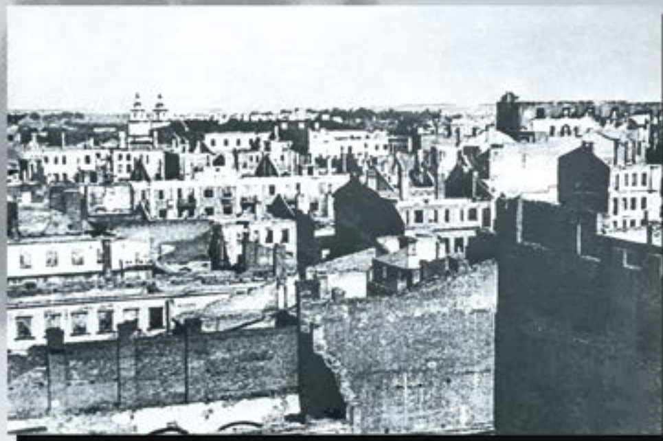
Разрушения в г. Минске
